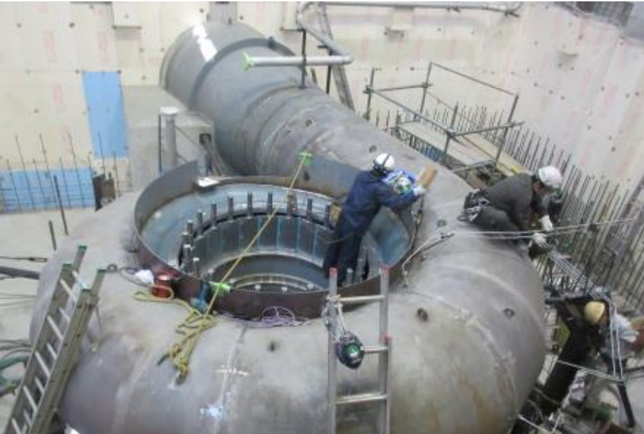
水車を据付中
