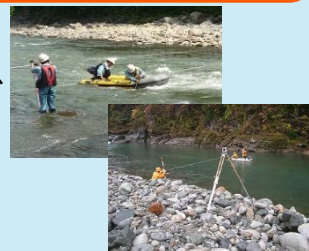
流量調査・測量作業
