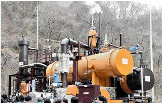
バイナリー地熱発電所 (400 kW)
