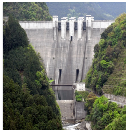
2,900kW 四国中央市、ダム
