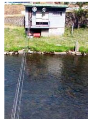
<発電事業者による 流量観測所>
