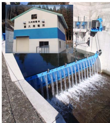
990kW 霧島市、一般河川
