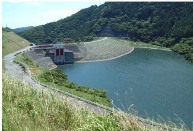
四時ダム（福島県いわき市）
