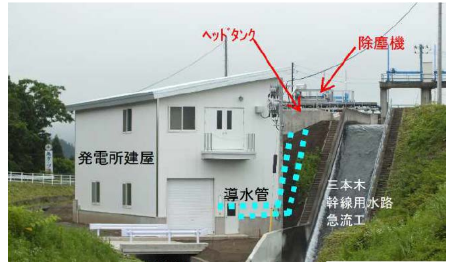
稲生川小水力発電所 (182 kW)
