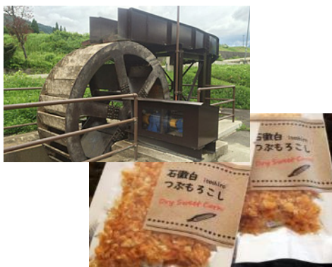
石徹白発電所（岐阜県郡上市）
